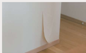
壁紙補修・張り替え
